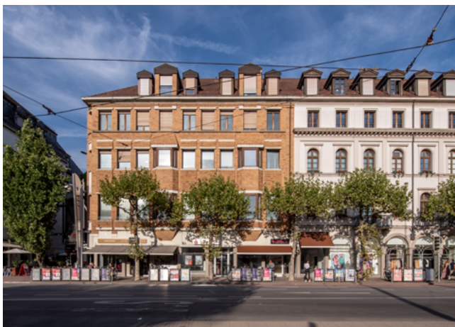
Abb. 1 | Darmstädter Hof Centrum, Gerhard Hauss und Hans-Peter Walla, Heidelberg, Sofienstraße 9, erbaut 1979
