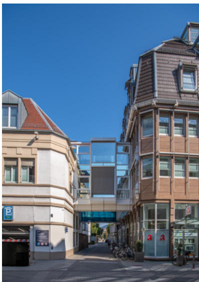
Abb. 3 | ATOS Klinik, Hauss, Walla + Partner, Übergang zum Westflügel und Übergang zur Atos-Carré, Heidelberg, Schneidmühlstraße 21
