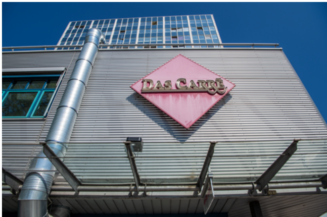
Abb. 1 | Das Carré, Jakob Wilhelm Mengler, Südseite an der Kurfürsten-Anlage, Heidelberg, Rohrbacher Straße 6–8, erbaut 1961, umgebaut 1993–94
