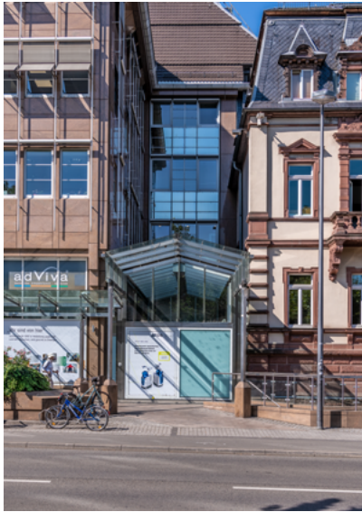
Abb. 1 | ATOS Klinik, Hauss, Walla + Partner, Gesamtansicht Glaspassage als Verbindung zwischen Alt und Neu, Heidelberg, Bismarckstraße 15, erbaut 1991
