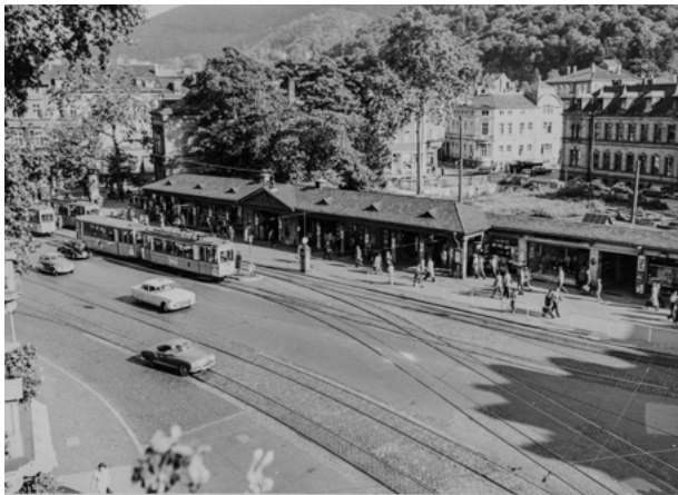
Abb. 3 | Arkaden am Bismarckplatz, Blick von HSB-Verwaltungsgebäude, Heidelberg, Bergheimer Straße 1, erbaut 1925
