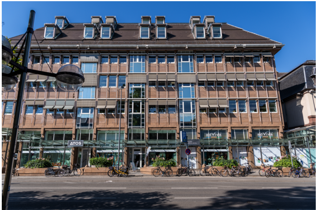
Abb. 1 | ATOS-Klinik, Hauss, Walla + Partner, Gesamtansicht Ostfassade, Heidelberg, Bismarckstraße 15, erbaut 1991
