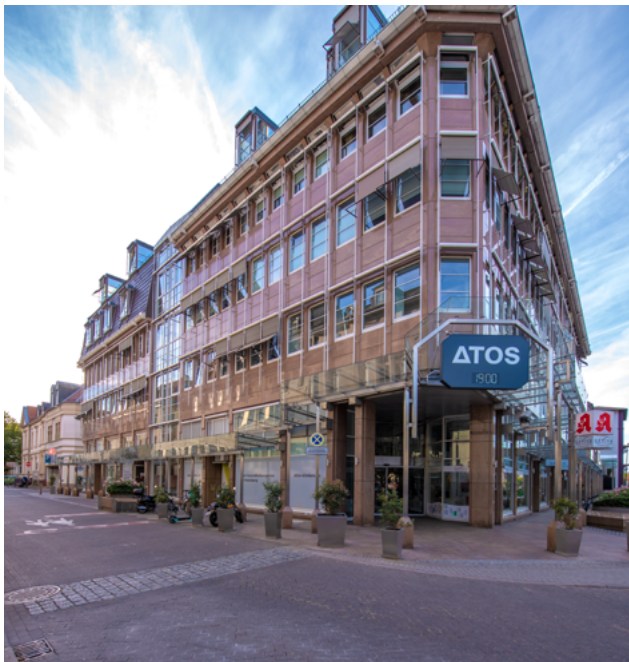
Abb. 2 | ATOS-Klinik, Hauss, Walla + Partner, Südfassade, Heidelberg, Bismarckstraße 15, erbaut 1991
