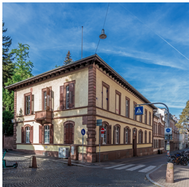
Abb. 2 | Verbindungshaus des Vereins Deutscher Studenten zu Heidelberg , Gesamtansicht, Alfred Friedrich Buntschli, Heidelberg, Plöck 68, September 2022
