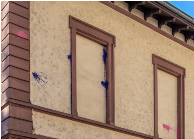
Abb. 1 | Verbindungshaus des Vereins Deutscher Studenten zu Heidelberg , Detail Fassade, Alfred Friedrich Buntschli, Heidelberg, Plöck 68, September 2022
